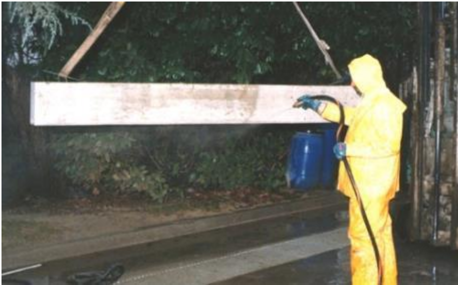
Sabbiatura della superficie di applicazione del rinforzo
