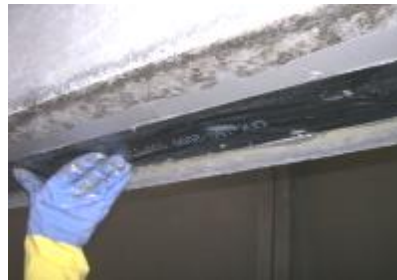
INCOLLAGGIO E FASCIATURA
