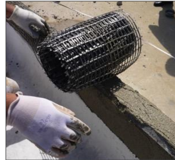
Applicazione delle fibre di carbonio
