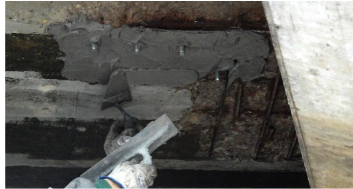
Applicazione di uno strato di circa 2mm di resina.
