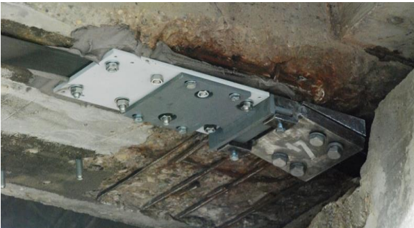
Inserimento del laminato all'estremità fissa
