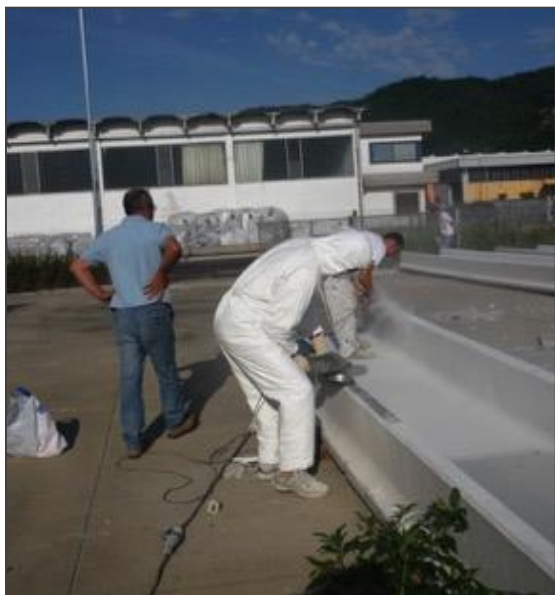
Preparazione della superficie
