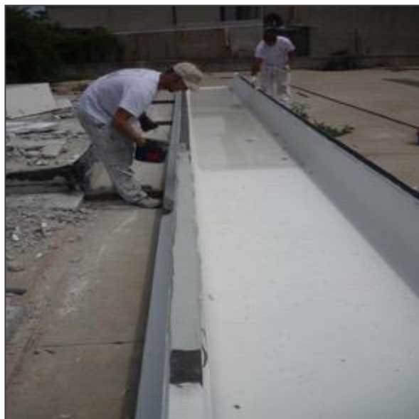
Applicazione della resina epossidica
