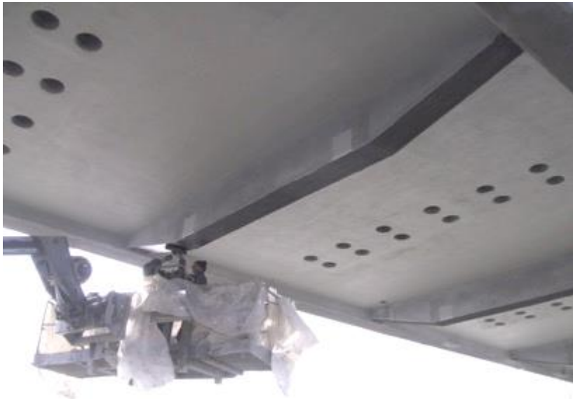
Rinforzo di traversi di impalcati da ponte
