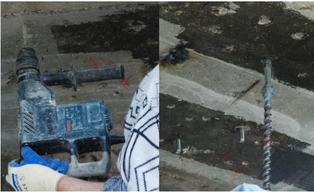
Foratura delle travi per inserimento bulloni.
