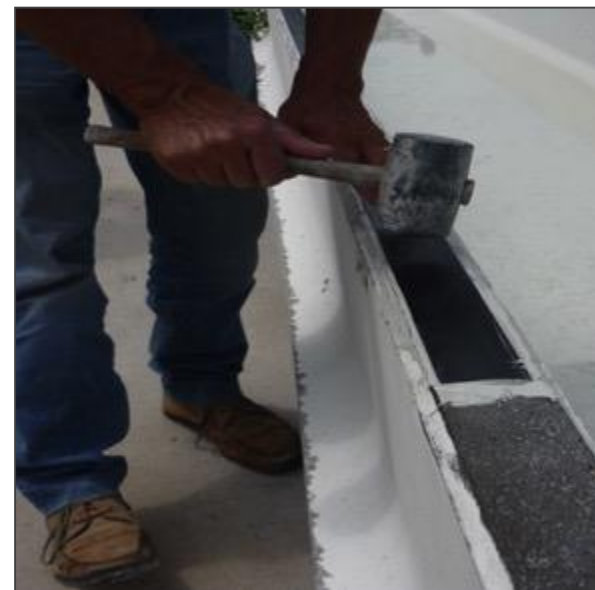
Applicazione del laminato
