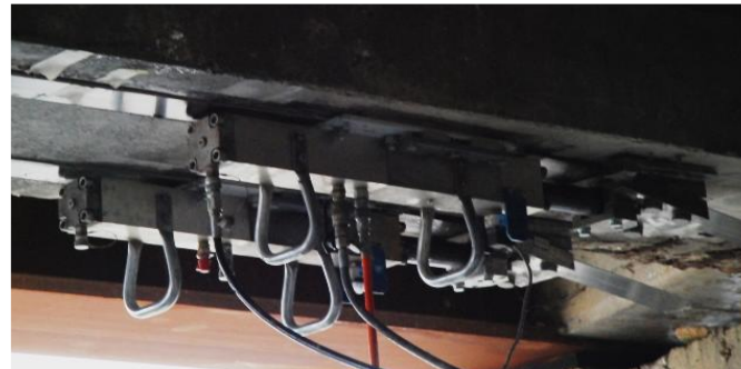
Spinta dei martinetti idraulici sugli ancoraggi mobili all'interno dei quali è ammortato il laminato.
