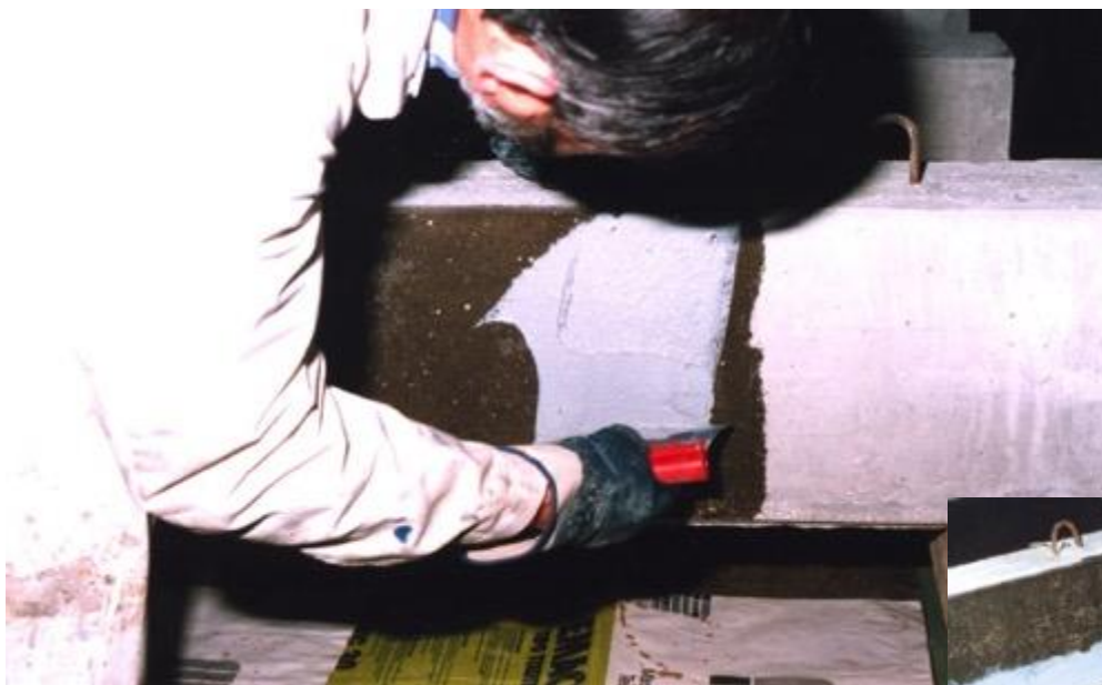
Operazione di rasatura della superficie
