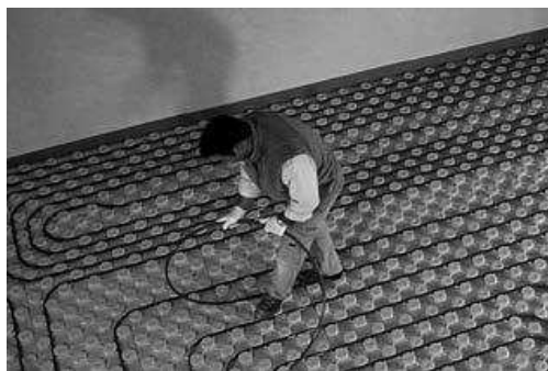
Figura 99. Posa delle tubazioni.
