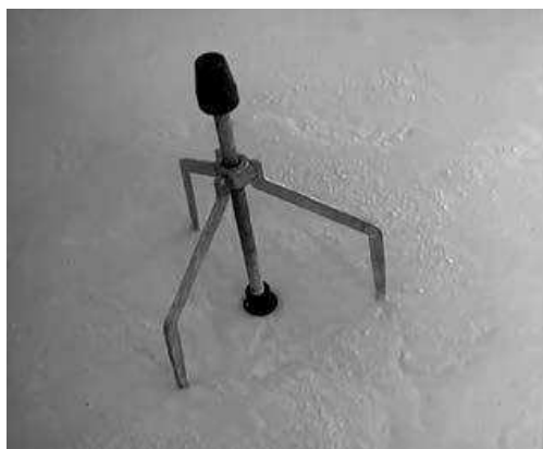
Figura 156. Fasi di posa del massetto liquido. Fonte: KNAUF.
