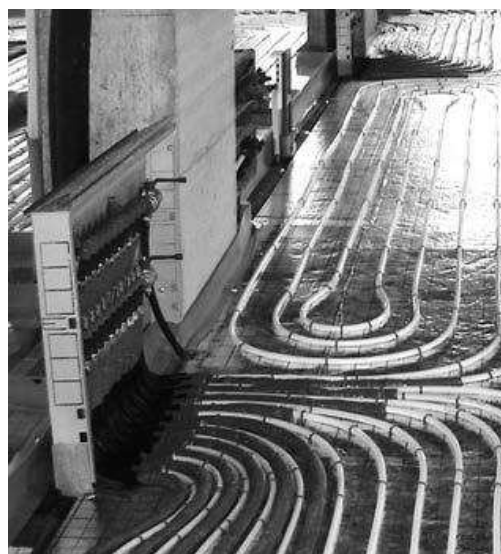
Figura I 20. Collettore e tubazioni nel sistema con isolante liscio.
