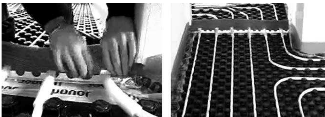
Figura 102. Posa del giunto di dilatazione.
