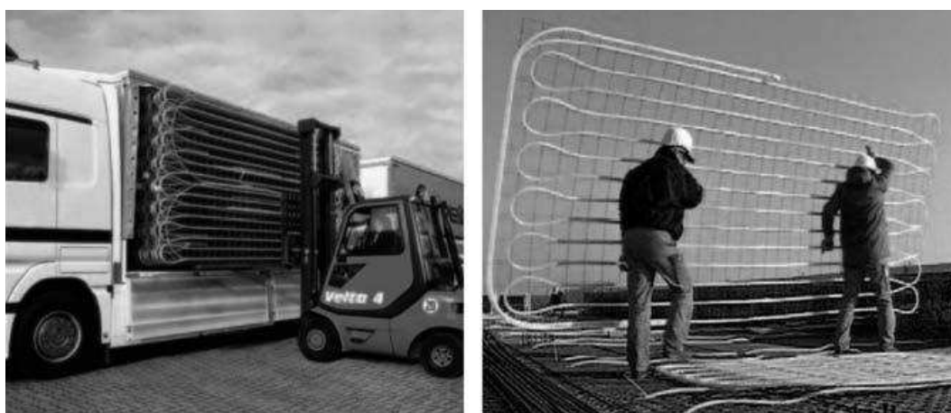
Figura 151. Posa delle serpentine nelle travi predalle (a sinistra) e posa dell'isolante (a destra).
