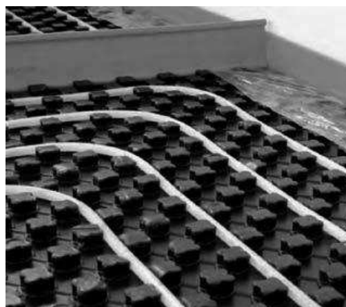
Figura 111. Lastra isolante, tubazione e striscia perimetrale nel sistema con lastra preformata.
