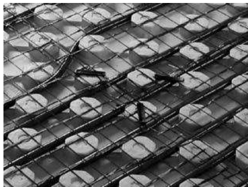
Figura 107. Rete di rinforzo in fibre.
