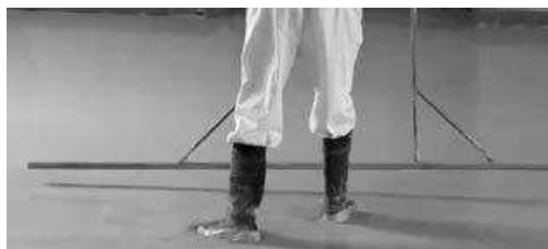
Figura 157. Operazione di staggiatura e livellatura. Fonte: KNAUF.
