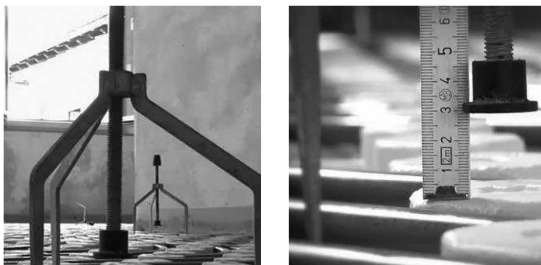
Figura 155. Piedi per la misura livello del massetto fluido (a sinistra) e controllo dello spessore (a destra). Fonte: KNAUF.
