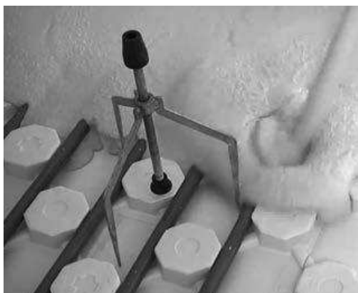
Figura 156. Fasi di posa del massetto liquido. Fonte: KNAUF.
