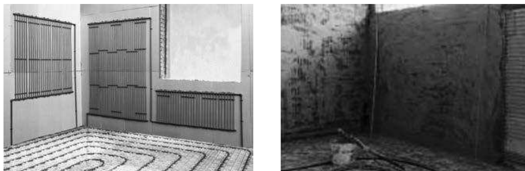
Figura 148. Moduli prefabbricati per le applicazioni a parete (a sinistra) e intonacatura (a destra).
