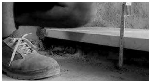
Figura 98. Controllo della quota dell'impianto.
