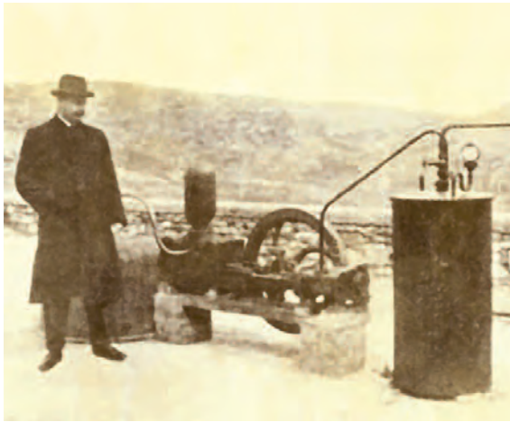
Fig. 22 - Il Principe Piero Ginori Conti ed il primo esperimento di generazione di energia elettrica con vapore geotermico. Larderello, Toscana, 1904.
