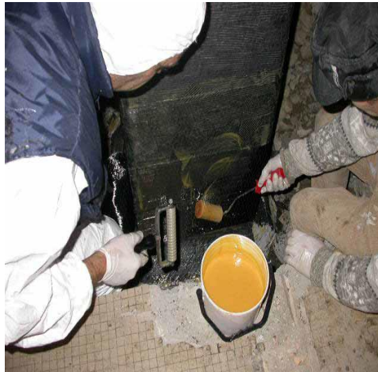
Applicazione secondo strato epossidico
