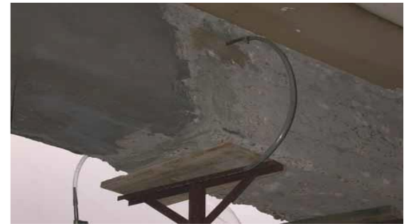
Passivazione armature e riparazione fessure
