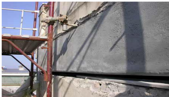
Preparazione substrato
