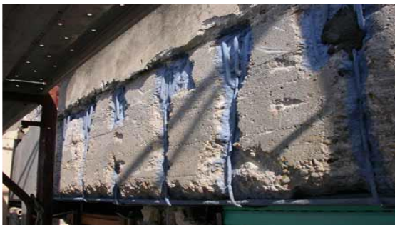
Ricostruzione sezione ove necessario
