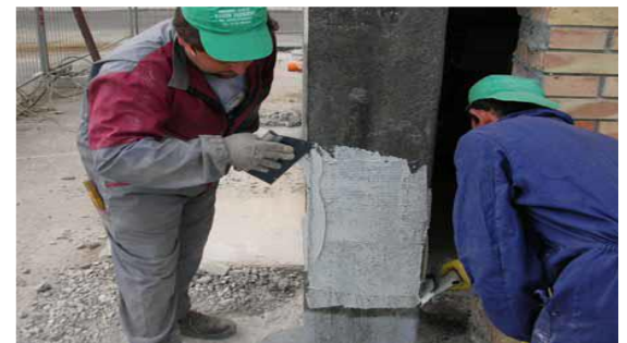
Applicazione primo strato epossidico
