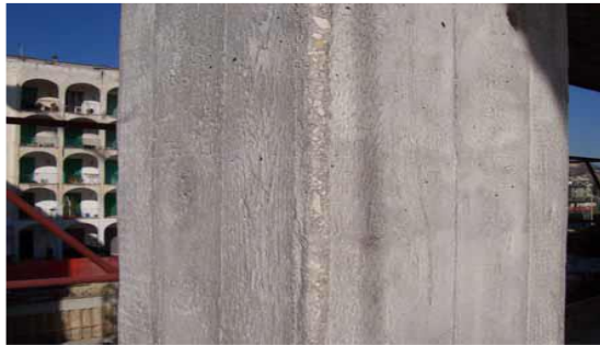
Riprofilatura degli spigoli vivi
