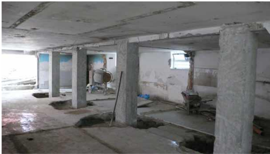
Rimozione dell'intonaco
