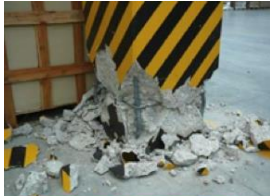
Formazione di cerniere plastiche
