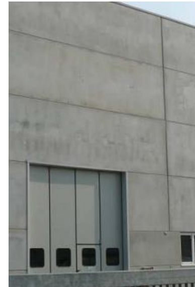
Tamponamento esterno ai pilastri con pannelli prefabbricati orizzontali
