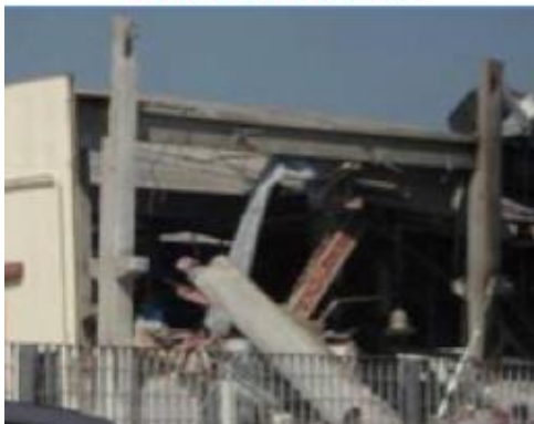
Perdita di verticalità
