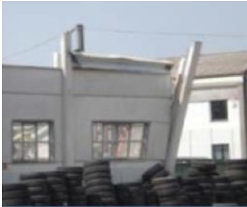
Perdita di verticalità
