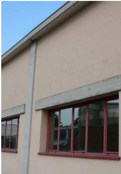
Tamponamento in luce di pilastro con muratura in laterizio
