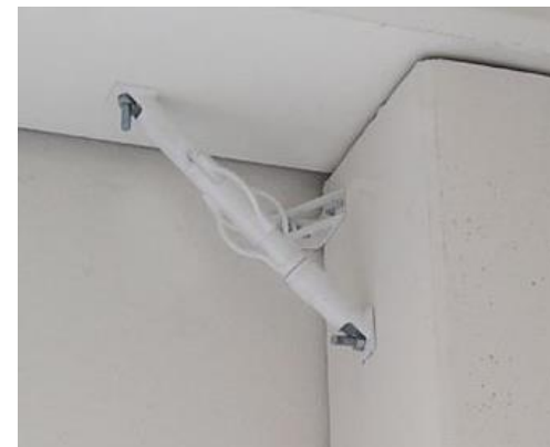
Figura 85 - Aggiunta di meccanismi di dissipazione: dissipatore ad attrito
