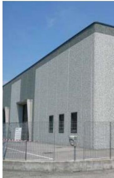
Tamponamento esterno ai pilastri con pannelli prefabbricati verticali
