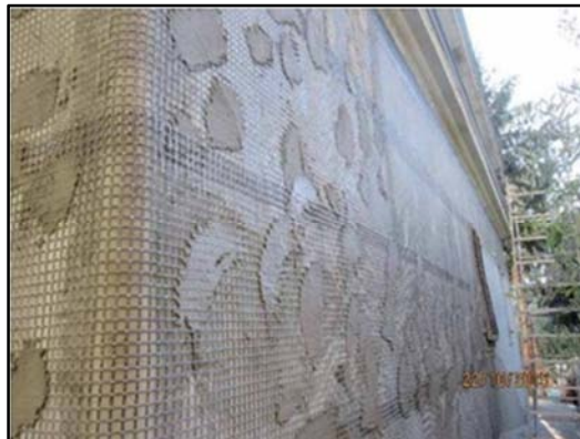
Figura 2.1 – Rinforzo di pannelli murari con rete di basalto.
