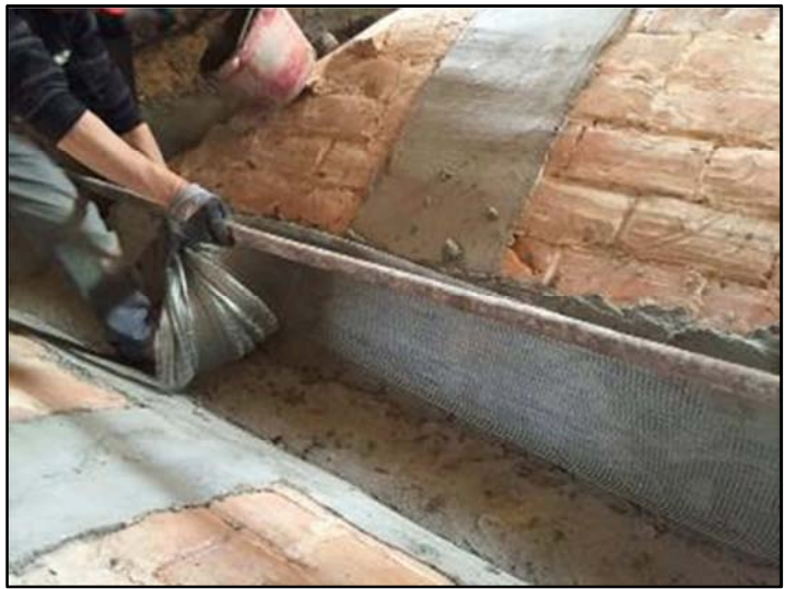
Figura 2.2 – Rinforzo estradossale di volta in foglio mediante placcaggio diffuso con rete in fibra di basalto installata con malta a base di calce idraulica.
