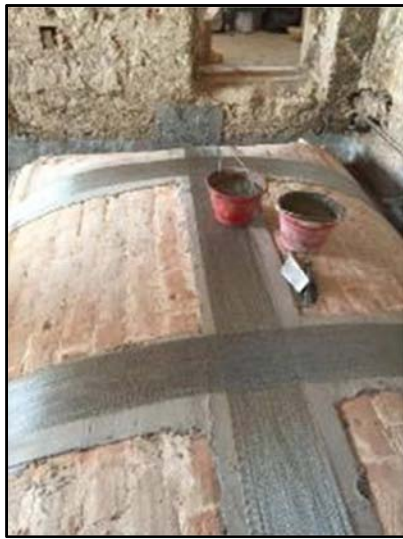
Figura 2.2 – Rinforzo estradossale di volta in foglio mediante placcaggio diffuso con rete in fibra di basalto installata con malta a base di calce idraulica.
