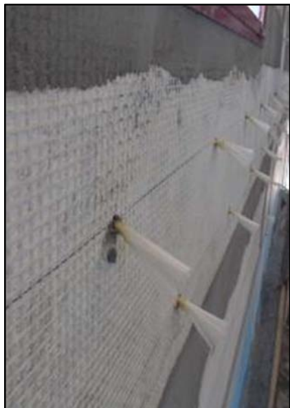
Figura 2.20 – Rinforzo antiribaltamento di pareti con un sistema FRCM, costituito da rete di fibra di vetro, malta, promotore di adesione e fiocchi di fibra di vetro.
