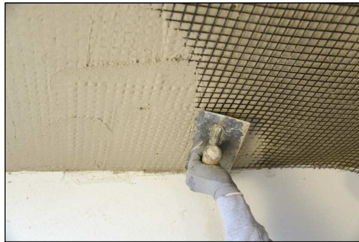
Figura 2.18 – Rinforzo di un solaio (antifondellamento).
