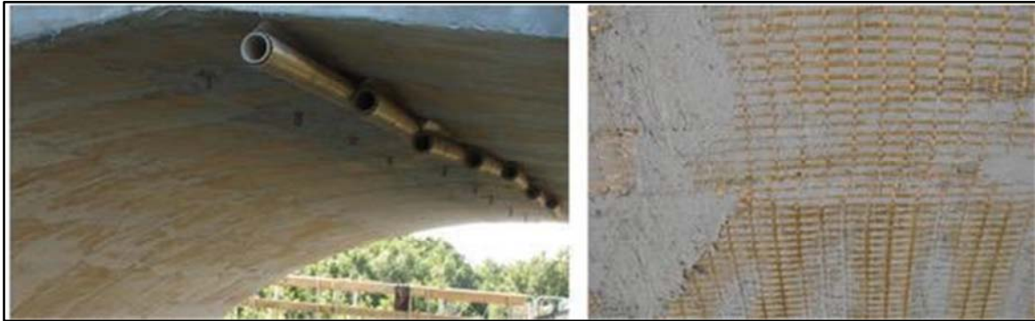
Figura 2.22 – Rinforzo intradossale di un ponte ad archi in calcestruzzo con reti di PBO.
