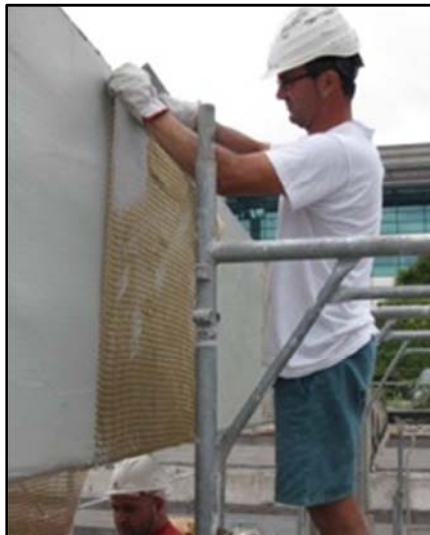
Figura 2.12 – Rinforzo a taglio di una trave con rete di PBO.
