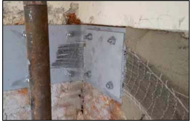
Figura 2.6 – Cordolature di piano realizzate con tessuti di PBO e acciaio.
