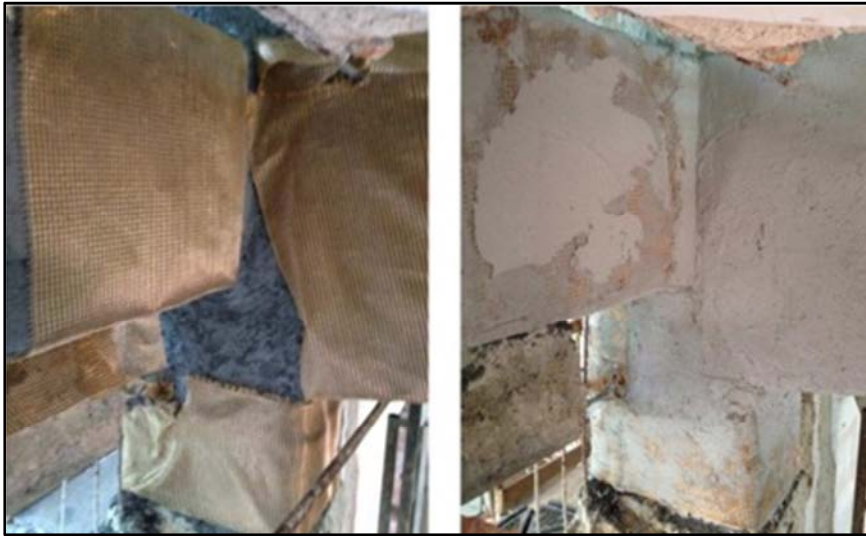
Figura 2.15 – Rinforzo di nodi travi-pilastro.
