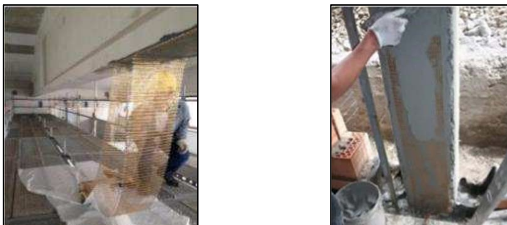
Figura 2.10 – Rinforzo flessionale di una trave e di un pilastro con rete di PBO.
