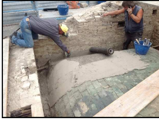
Figura 2.2 – Rinforzo estradossale di volta in foglio mediante placcaggio diffuso con rete in fibra di basalto installata con malta a base di calce idraulica.
