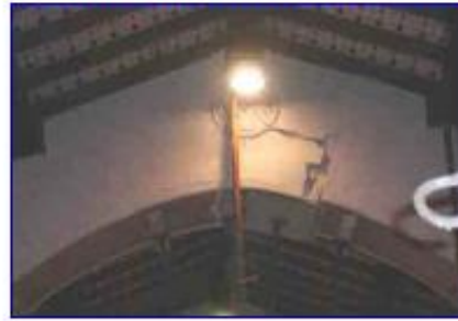
Rottura in chiave dell'arco trionfale
