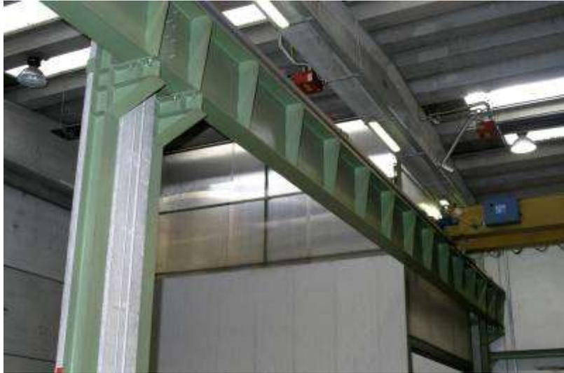
Figura 15: Vie di corsa del carroponete
