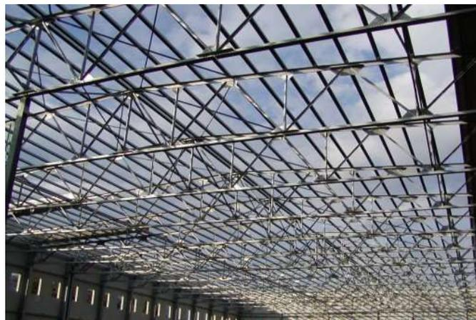
**Figura 7: Esempio di copertura a capriate**
