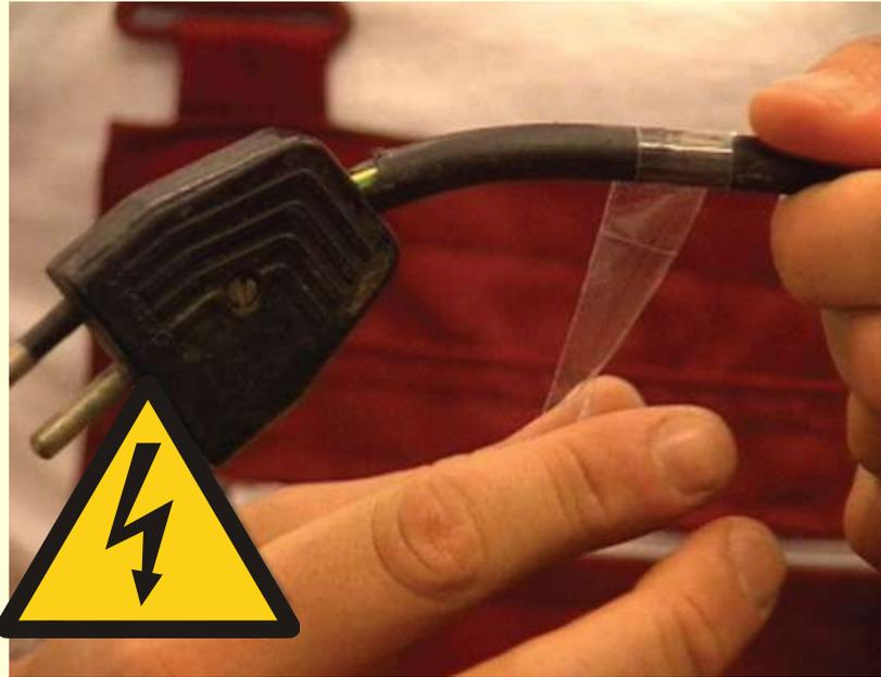
La spina rotta va sempre sostituita: evitate nastrature pericolose!
